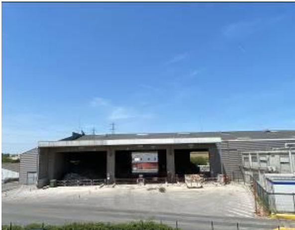
Bâtiment (Façade Sud)
