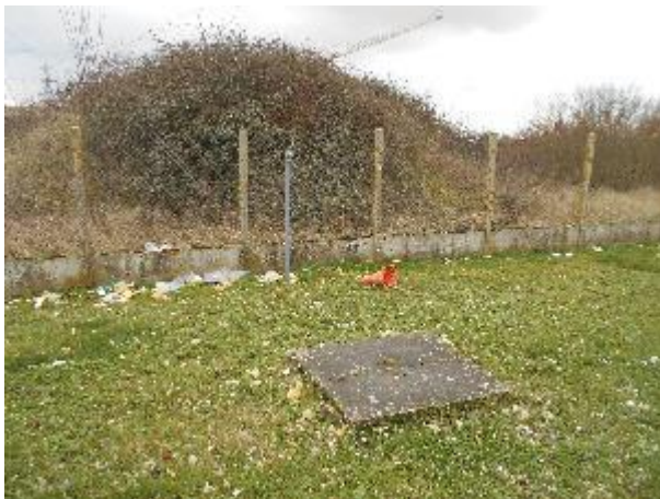
Emplacement cuve GO
